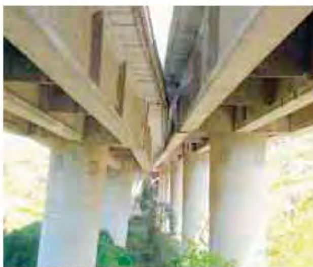
UN'IMMAGINE DEL VIADOTTO DOPO IL CEDIMENTO
